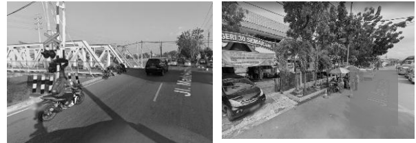
Gambar 9. Lokasi yang membutuhkan jalur penyeberangan.
