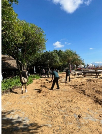
Gambar 4. Kondisi Jalur Segmen 4 Sumber : Dokumentasi Penulis, 2025
