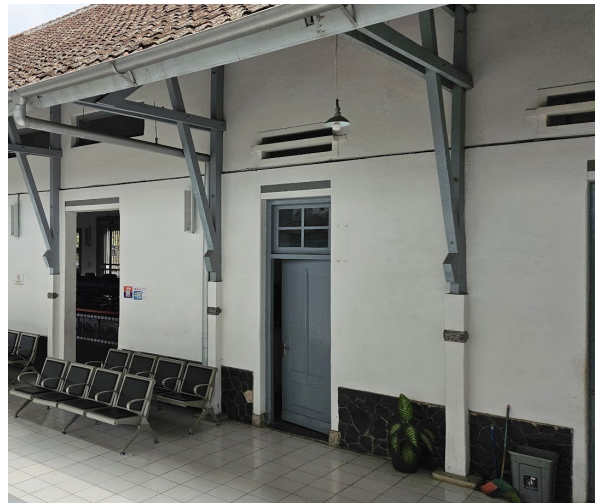
Gambar 7. Struktur konsol pada sisi peron stasiun
