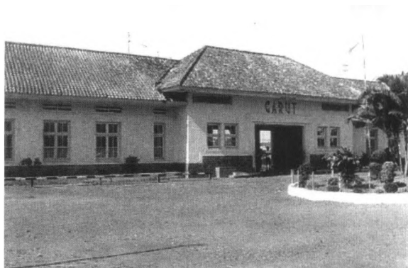
Gambar 9b. Bangunan Stasiun Garut tahun 1949
