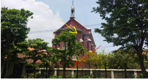
Gambar 13. Bidang dinding yang memiliki ketebalan 60 cm (panah merah) pada sisi bawah dan ketebalan 50 cm (panah kuning) pada sisi atas
