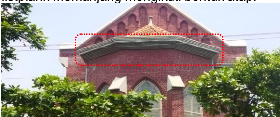
Gambar 9. Ornamen profil listplank pada atap separuh limasan segienam
