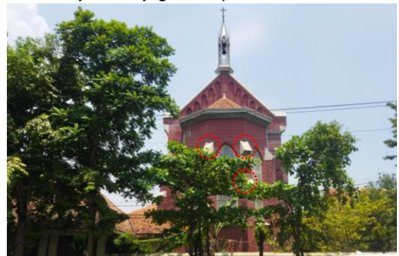
Gambar 16. Warna merah pada pasangan batu bata ekspos dan warna abu-abu muda (lingkaran merah) aksent pada profil dan ornamen kolom
