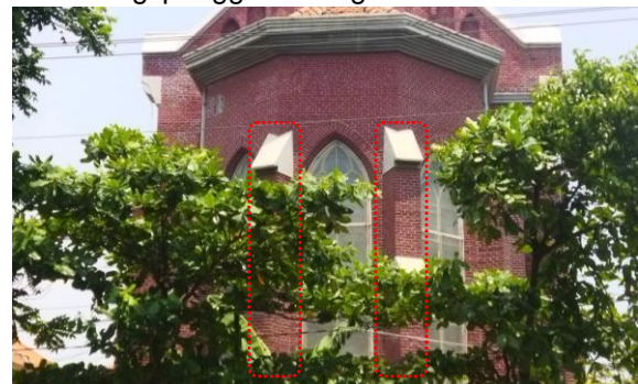
Gambar 12. Kolom pada fasad bangunan kapel
