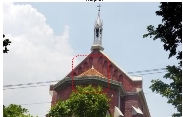
Gambar 6. Atap separuh limasan segidelapan di atas ruang Panti Imam
