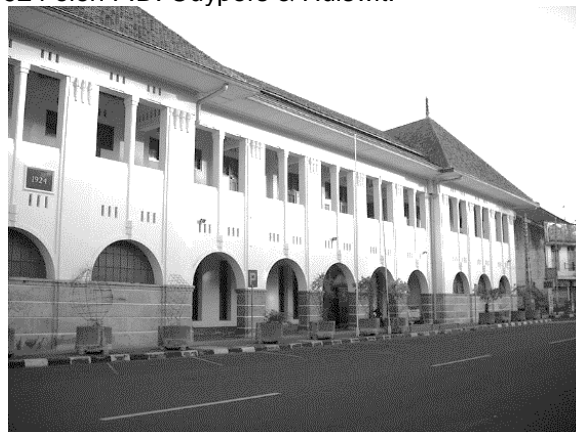
Gambar 13. Gedung BAT, Cirebon. (Sumber: detik.com)
