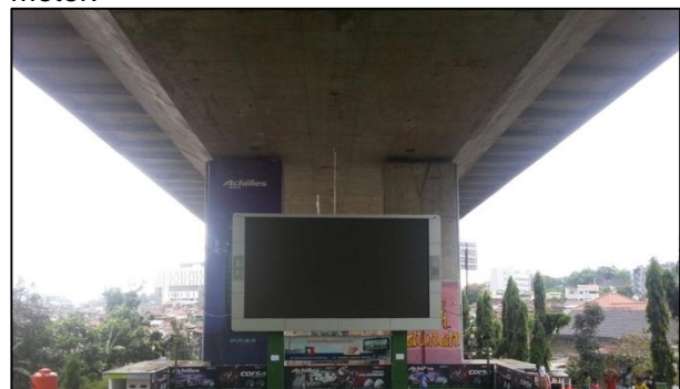
Gambar 2. Jalan Layang Pasupati sebagai elemen Overhead plane dari Taman Film
