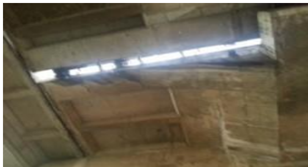
Gambar 6. Sambungan Beton pre-prabrikasi Jalan Layang
