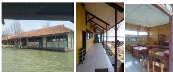
Gambar 7. Kondisi Sekolah SD Bedono 1
