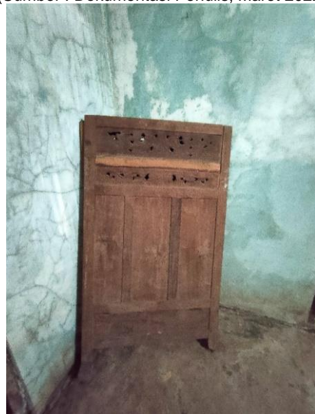
Gambar 16. Dinding Slintru pada rumah masyarakat kampung pitu (Sumber : Dokumentasi Penulis, Maret 2022)
