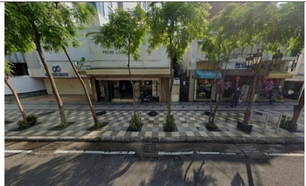
Gambar 10. Sumur resapan di Jalan Tunjungan
