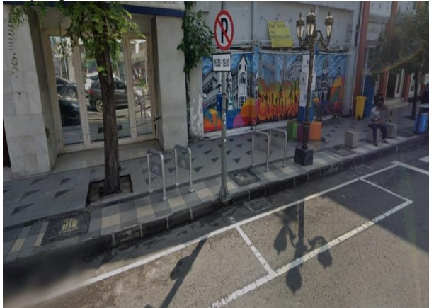
Gambar 8. Fasilitas parkir sepeda pada streetscape Jalan Tunjungan
