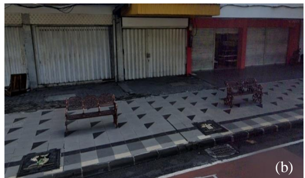
Gambar 7. Susunan tempat duduk (a) semen dan (b) besi pada streetscape
