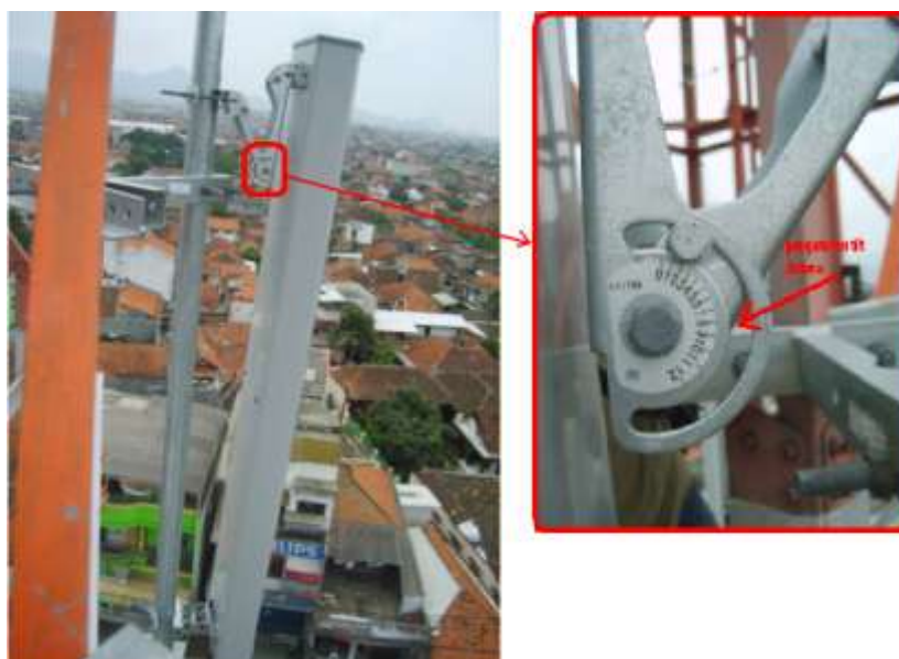
Gambar 7: Pengaturan kemiringan antena
