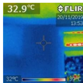
Gambar 13. Dinding dalakam ruang CH5
