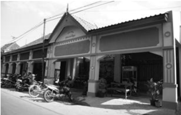
Gambar 13. Kondisi pertengahan 2008, setelah jalur pedestrian selesai dibangun
